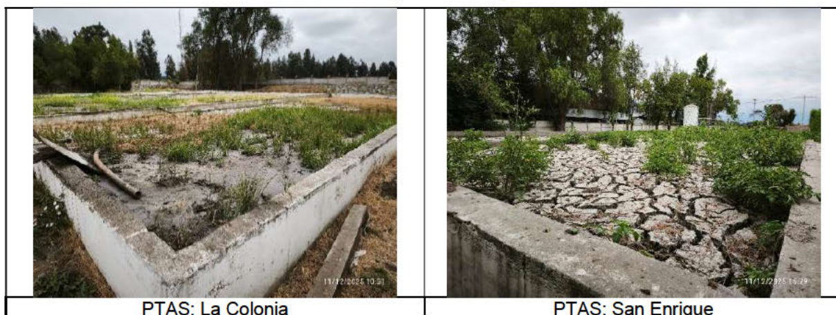
Imagen N° 9: Disposición de los lodos en las canchas de secado en las PTAS La Colonia y San Enrique.
