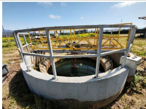
2. Sedimentador en desuso
